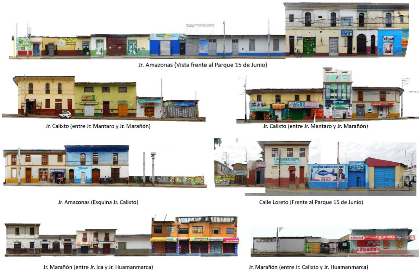
Figura 3. Vistas de edificaciones en las vías Calixto y Amazonas del AUM 15 de Junio. Fuente: Composición elaborada con fotografías capturadas en noviembre del 2018.
